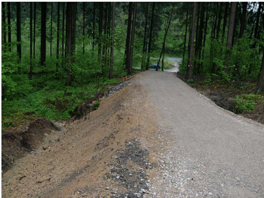
Zpevněné lesní cesty a hluboké příkopy rychle odvádějí vodu z lesů pryč. Foto: F. Jaskula
