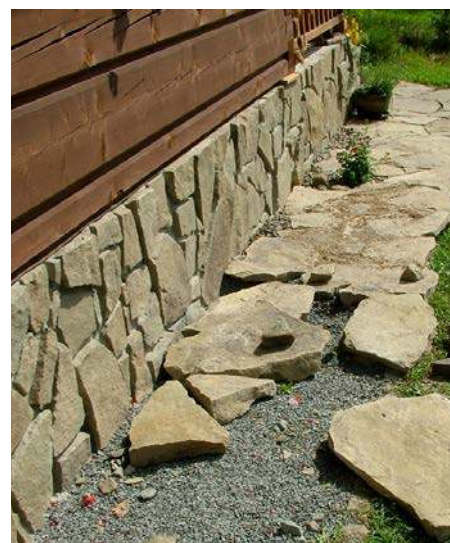
Chodník kolem domu nemusí být nutně vypsávaný betonem. Jednodušší řešení může být mnohem lepší. Foto: F. Šulgan
