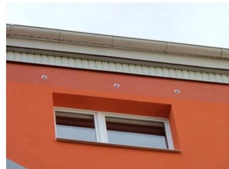
Ochrana přírody požaduje, aby podstřešní otvory nebyly při zateplování zakrývány. Pokud chce žadatel otvory estetizovat, může použít z krytky bílou kruhovou objímku, ale bez mřížky. Tak zůstanou otvory funkční pro netopýry i rorýsy
