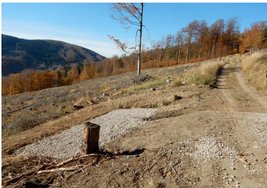
Jeden z deseti zasakovacích objektů vytvořených v prudkém svahu Malé Stolové v nadmořské výšce 900–1 020 metrů.
